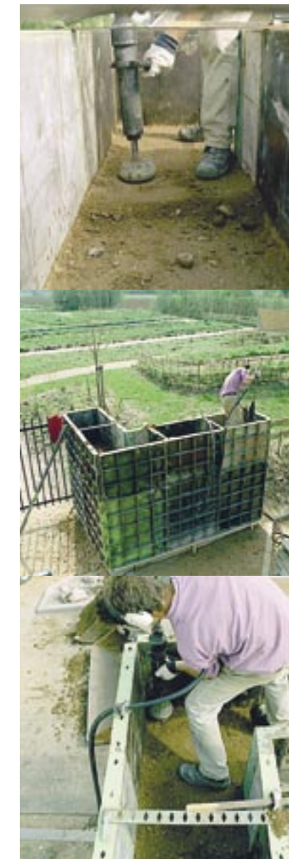
Laag voor laag wordt de stamplemen muur opgebouwd.
