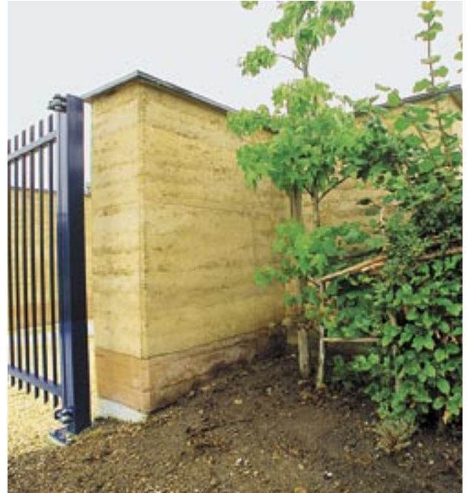
Een dragende stamplemen muur heeft een breedte van 40 tot 60 cm.
